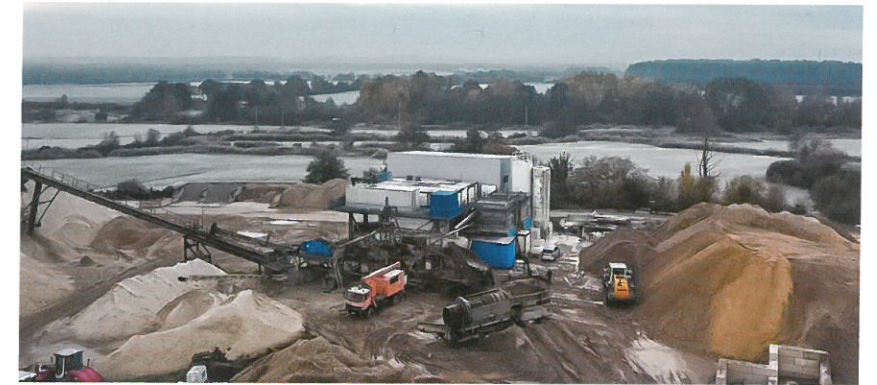
Das Unternehmen hat eine Sandwaschanlage mit Schlammmentwässerung zur Waschwasserrückgewinnung individuell entwickelt.
